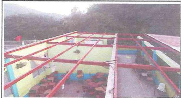
FOTO 2: Costaneras en mal estado por problemas de humedad, se necesita mantenimiento para alargar su utilidad. (EN PROCESO)
