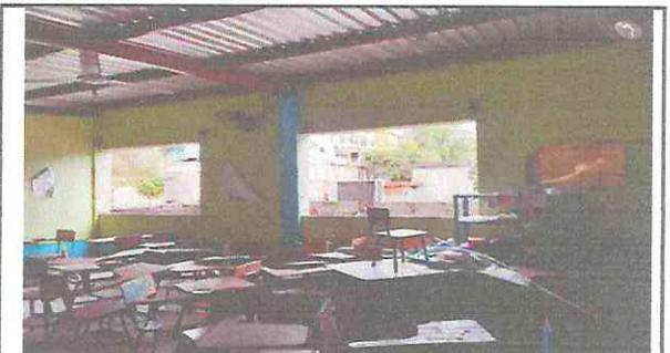
FOTO 6: Ventanales en mal estado, los cuales fueron removidos para su nueva instalación. (EN PROCESO)
