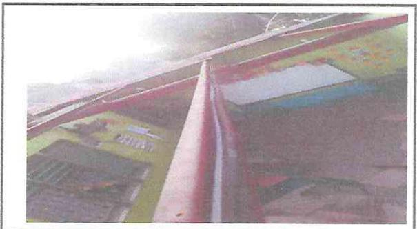
FOTO 4: Por el tiempo que tenían las costaneras se encontraban en mal estado, por lo cual se les brindará el mantenimiento correspondiente. (EN PROCESO)
