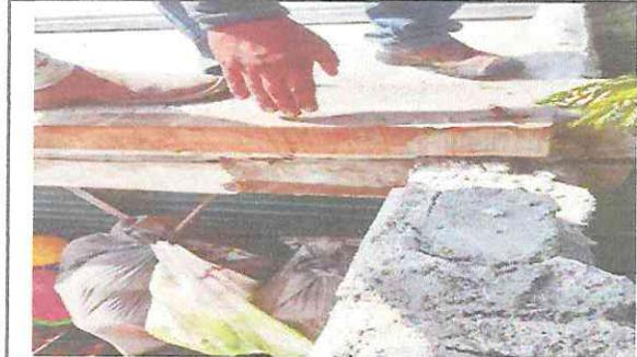
FOTO 1: Terraza no cuenta con desnivel de agua pluvial. (EN PROCESO)
