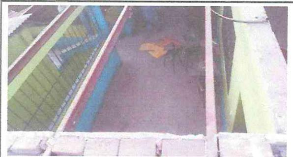
FOTO 5: Lámina removida por encontrarse en mal estado, en la cual se infiltraba el agua a los pasillos y salones en época de lluvia. (EN PROCESO)
