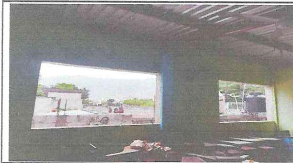
FOTO 3: Como se puede observar fueron removidas los ventanales con sus ventanas de paletas, ya que se encontraban en mal estado y en temporal de lluvia el agua ingresaba a los salones (EN PROCESO).
